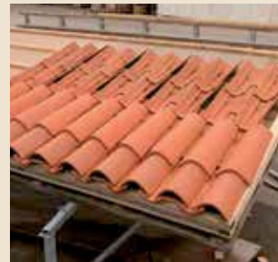
8- الاستمرار في تركيب قرميد الكونيك عن طريق وضعها في المقاطع المعدة لها داخل قرميدة ال DCS التي في نفس الوقت تثبتها وتمنعها من الانزلاق . وبعدها اكمل في نفس الطريقة خط من ال DCS وغطيه بقرميد الكونيك .
