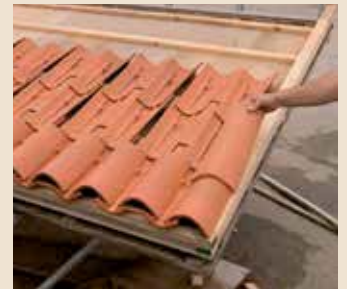
8- الاستمرار في تركيب قرميد الكونيك عن طريق وضعها في المقاطع المعدة لها داخل قرميدة ال DCS التي في نفس الوقت تثبتها وتمنعها من الانزلاق . وبعدها اكمل في نفس الطريقة خط من ال DCS وغطيه بقرميد الكونيك .
